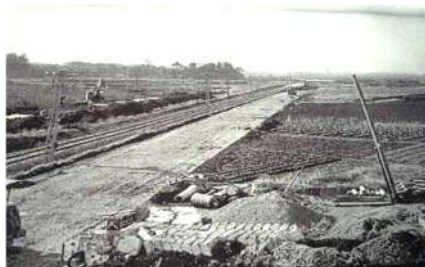
造成中の工業団地（昭和 40 年）
